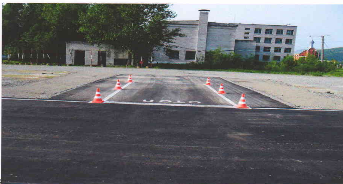
Зона испытательного упражнения по обучению водителей транспортных средств категории «С» - «Въезд в бокс задним ходом»
